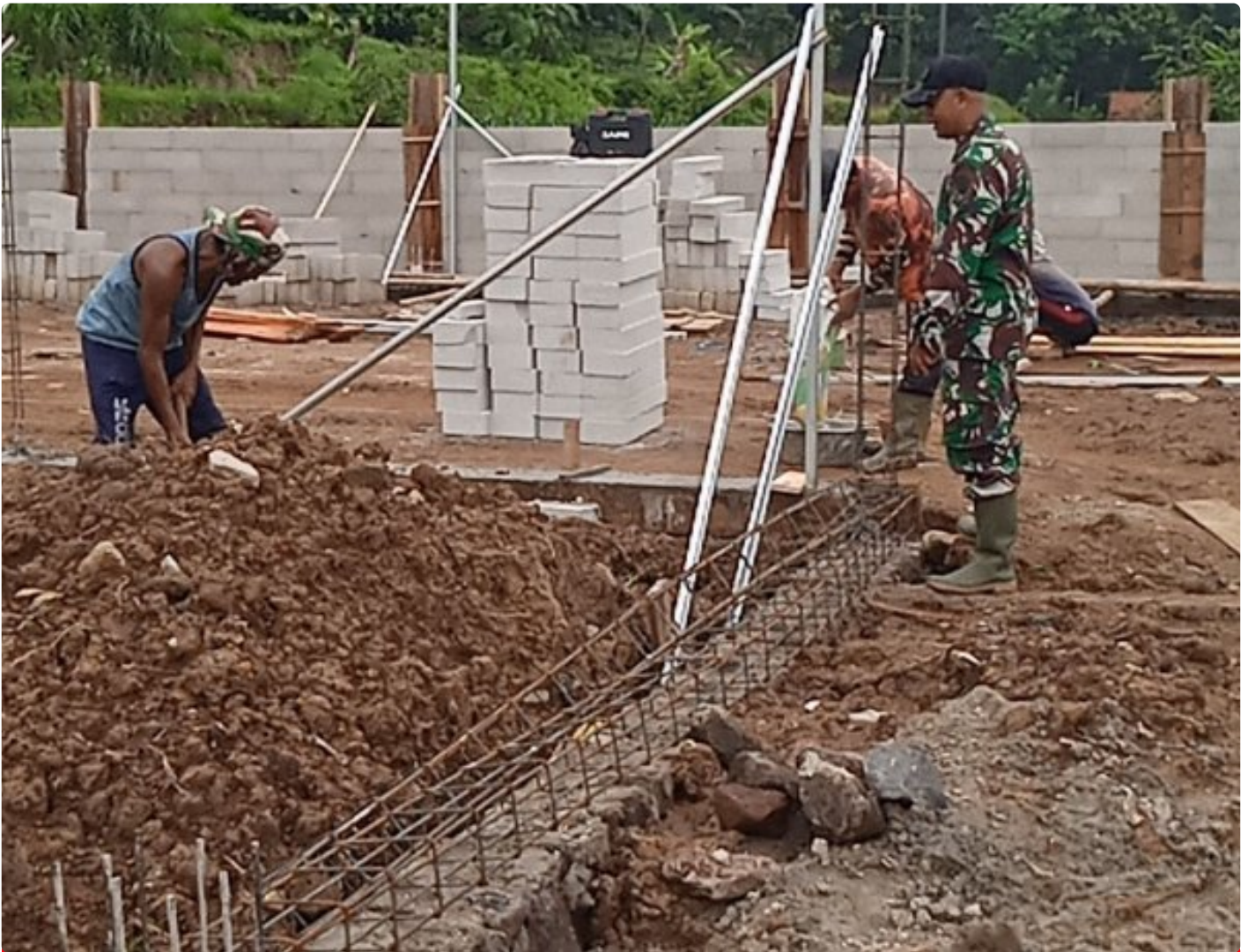
Pembangunan KDKMP Desa Cipicung
